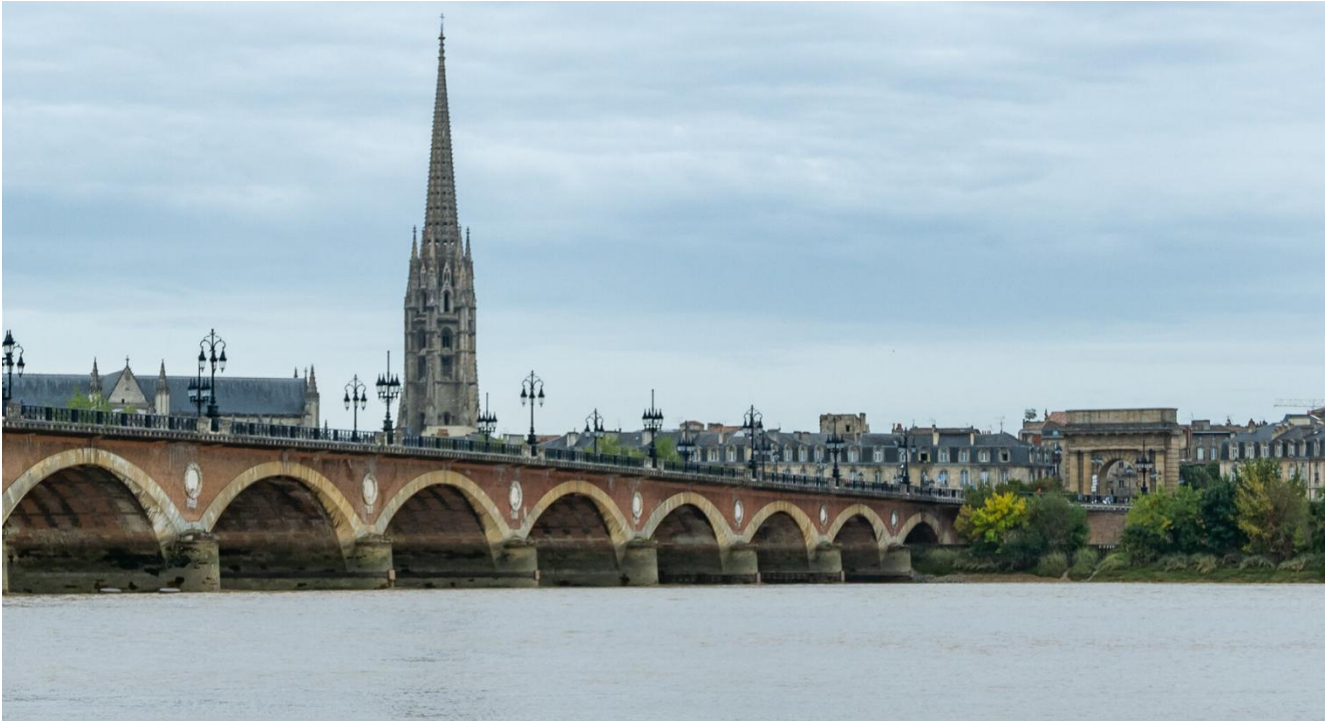
Figure 1. The Pont de Pierre of Bordeaux.
